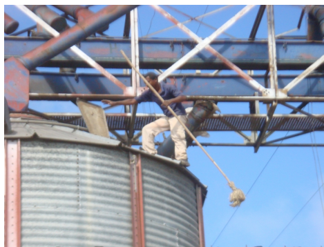
Figura 1 – Homem ao sair sozinho de um silo após realizar uma manutenção e sem nenhuma proteção.
